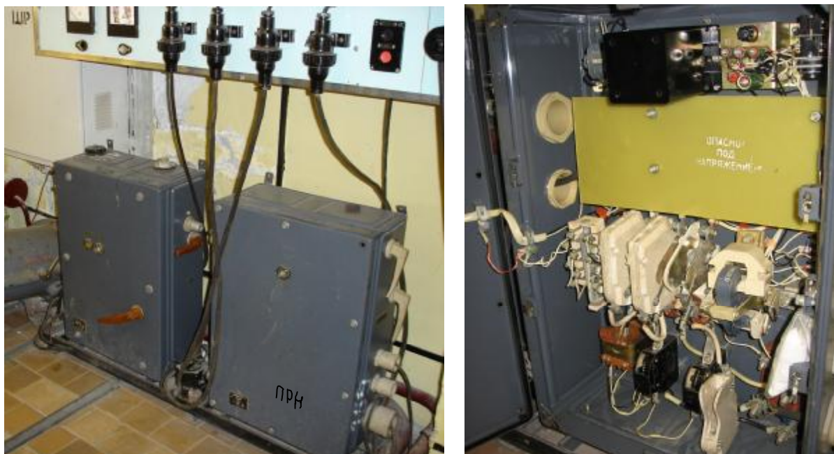
Рисунок 13 – Вид сборки из аппаратов рудничного нормального исполнения.
