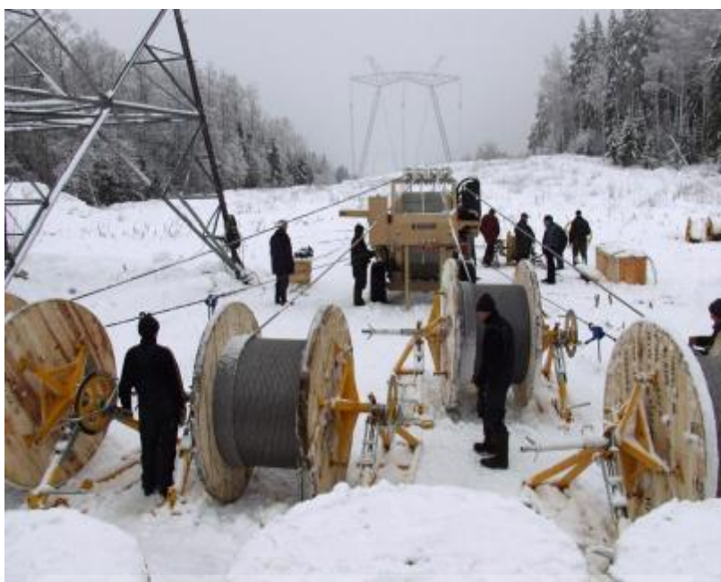
Рисунок 37 – Механизация раскатки проводов ВЛ (чтобы провод не упал при обрыве обвязки), а на кривых - на шейках (рис. 36), при этом изоляторы должны находится
